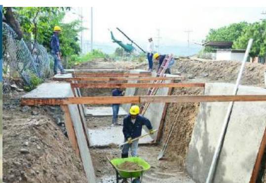
obras del colector pluvial de la Troncal del Caribe
