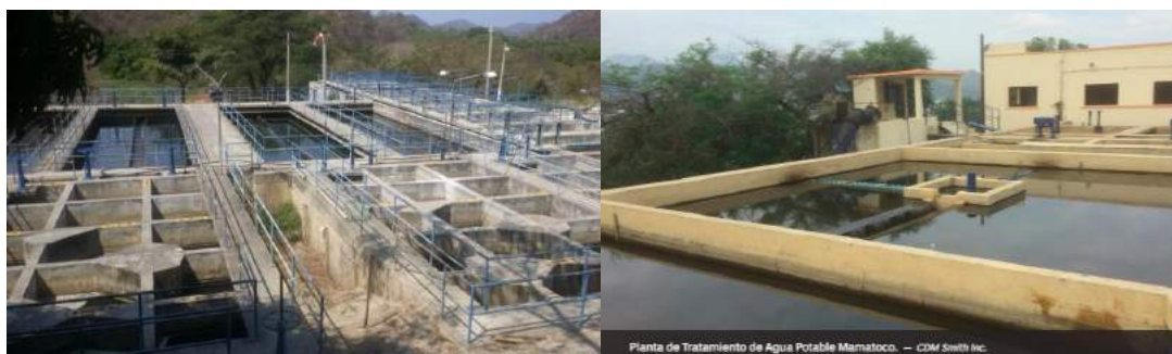
Planta de Tratamiento de Agua Potable de El Roble y Planta de Tratamiento de Agua Potable Mamatoco perteneciente al acueducto de Santa Marta.
